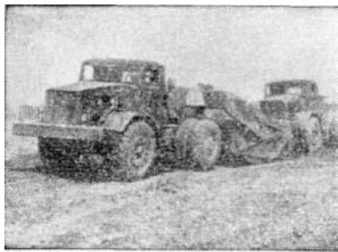
Испытания 15-кубового скрепера с 300-сильными толкачом и тягачом на Сталинградгидрострое.
